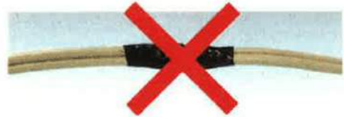
(写真) 断線部の補修
